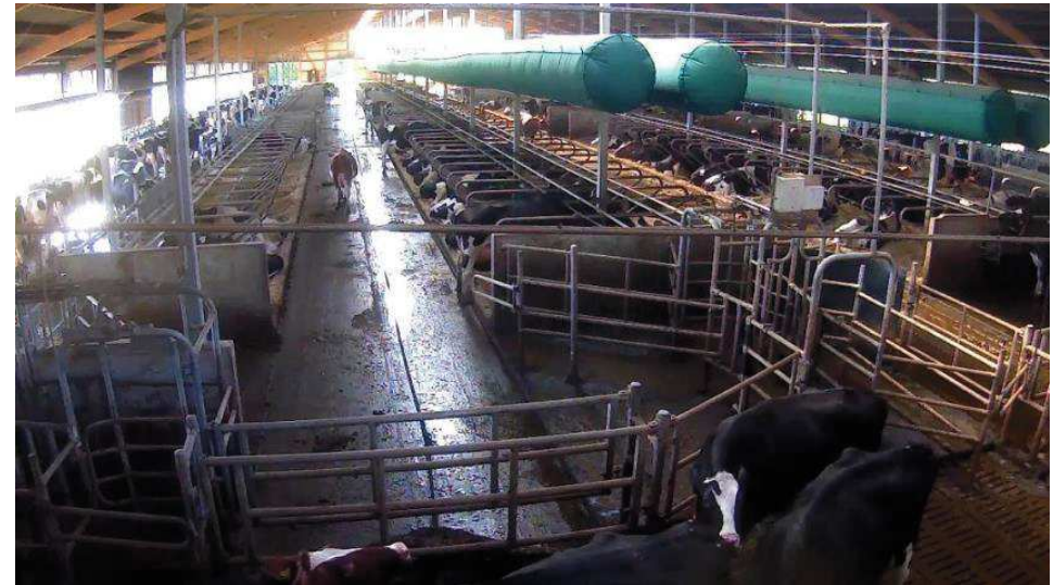
Einbau Belüftungsschläuche
